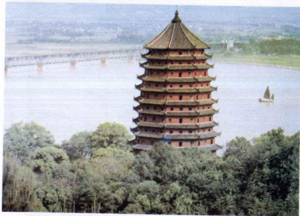
浙江杭州六和塔
