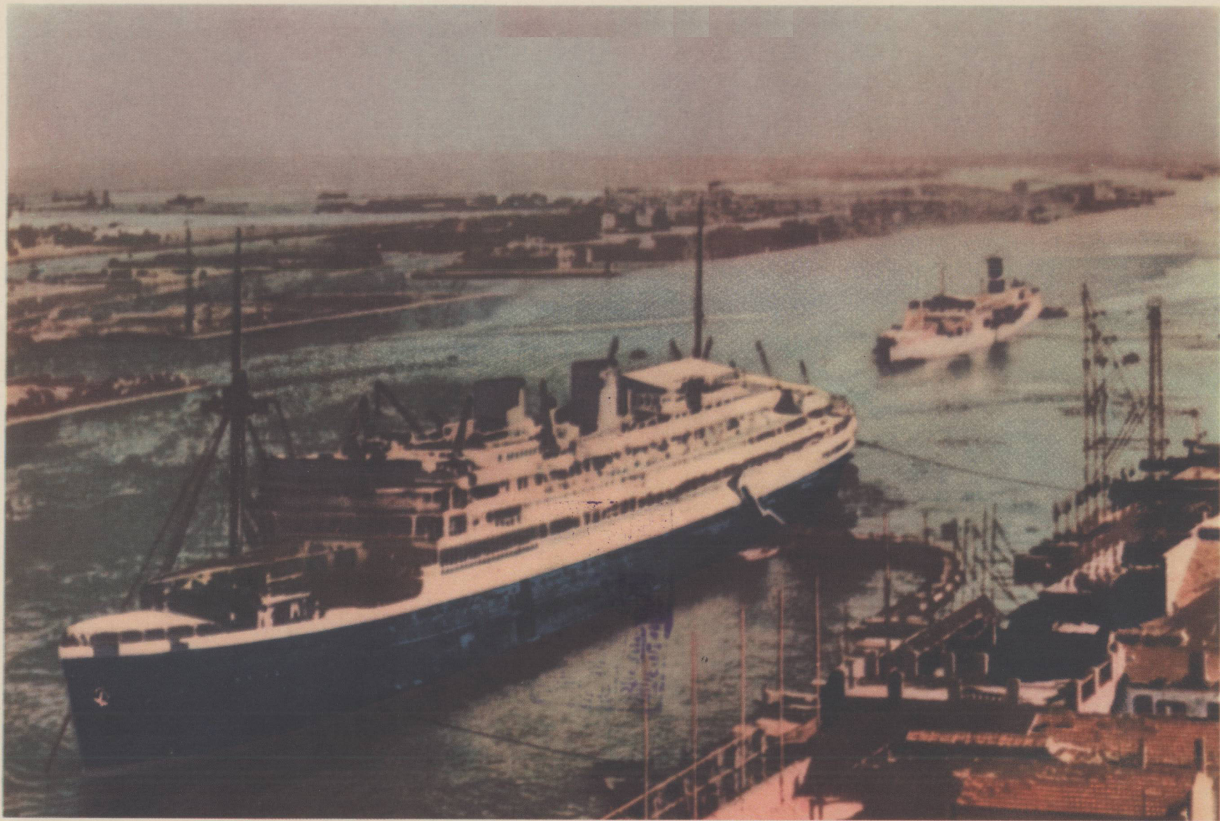
12. 苏伊士运河 苏伊士运河位于阿联境内，是亚非两洲的分界线，连接着地中海和紅海。1859—1869年开凿。全长173公里，河面宽80—150米，水深12.8—13.5米。4.6万吨以下的海輪可通航无阻。亚洲、澳洲到欧洲、非洲的航运，多半取道于此。其中北上的石油和南下的石油制品，运输量最多。苏伊士运河的水位同地中海、紅海相平，因此不設閘門。但有些河段，河面狹窄，大輪船只能单綫行駛，不能同时对开。
