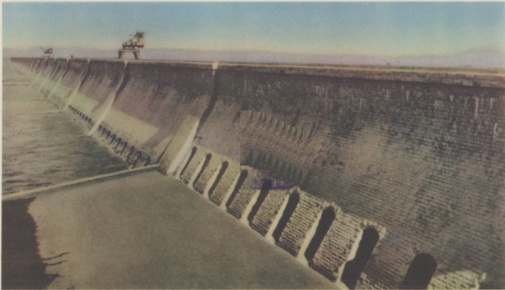
9. 非洲尼罗河上的阿斯旺水坝 阿联位于荒漠带内，气候十分干燥。尼罗河发源于非洲赤道附近，从上游干、支流带来大量河水，使阿联尼罗河两岸地区发展了绿洲农业。尼罗河夏秋水大，冬春水小。为了储蓄足够的春季用水，尼罗河上建了阿斯旺水坝。坝身长1,960米，高47米，顶宽12米，对阿联的农业生产起着一定的促进作用。
