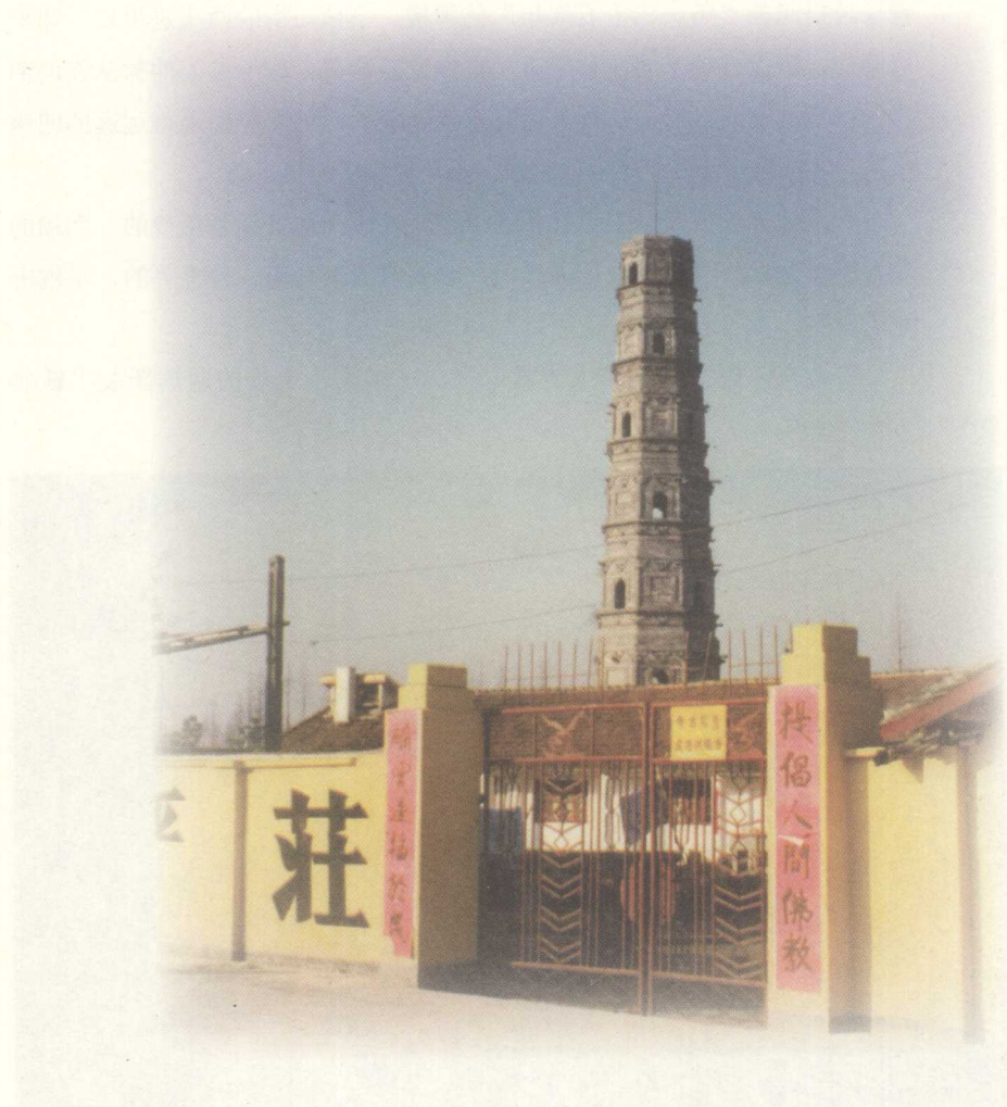
◎新修好的青龙塔
