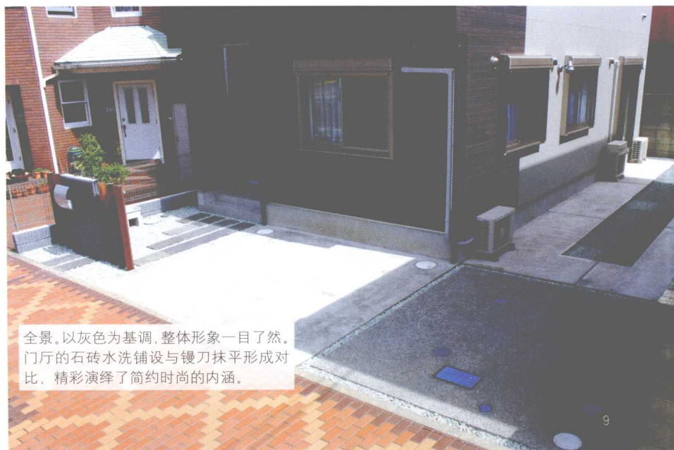
⑥远处的停车区，只在承载汽车轮胎的部分铺砌水泥板，中间部位铺砌砂砾。不但节约成本，还达到了良好的视觉效果。
