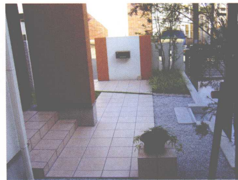
④ 通道的地面铺砌了色彩明亮的赤土瓷砖。
