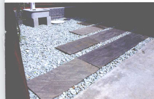
③平板纵向连接铺砌，呈线形。横向留出间隙，放入装饰砂砾。装饰砂砾下铺设除草垫，能够很好地防止杂草生长。
