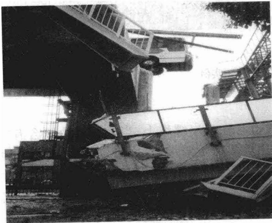
图 1.11 桥墩滑移(唐山大地震,1976)
