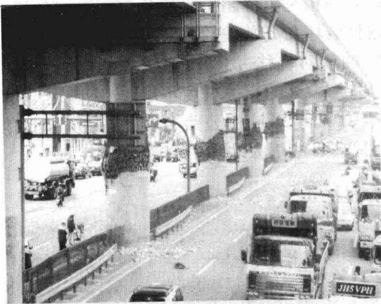
图 1.9 桥墩破坏(神户地震,1995)
