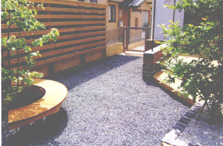
①在地上铺上防草垫，然后再铺“轻井泽烧石”。
