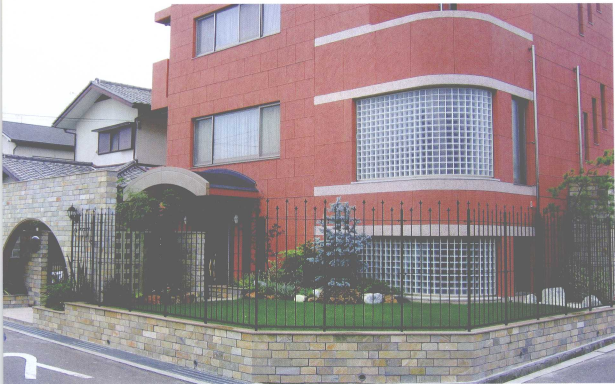
①施工后的全景。从外观上看，高高的铸铁栏杆使庭院空间凸显开放感。
