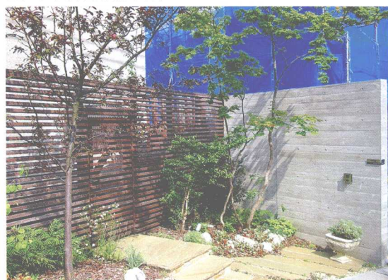
① 水泥墙的花样采用杉木条纹，还在上面安装了对讲机和时尚的门牌。
