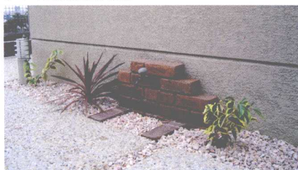
① 在停车场的内侧，用红砖砌了一个宠物洗脚池，在红砖中嵌入一个低矮的水龙头。
