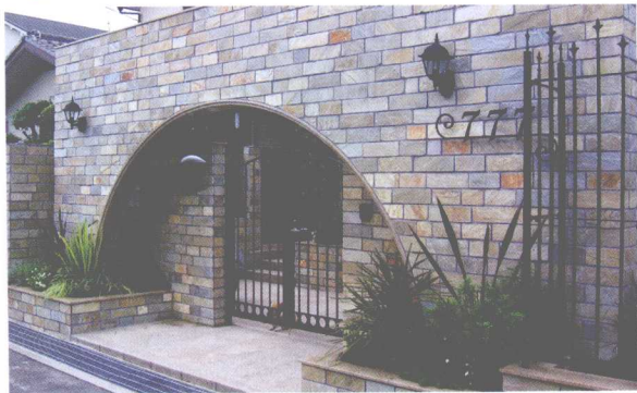
③大门周边。用方形石块贴在整个墙壁上，门洞改建成拱形，使大门显得更加有品位。在内侧门洞处还设立了门柱，使整个大门呈现立体感。
