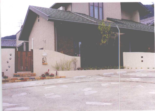
① 门前全景。和式房间前使用格子栅栏（照片正中央）。
