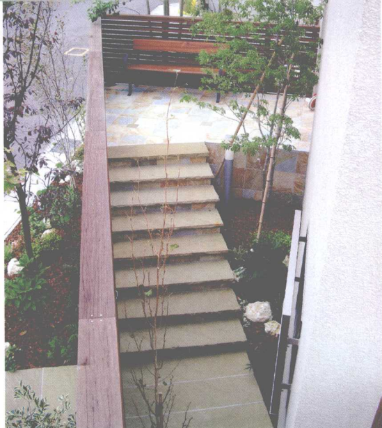
① 大门前台阶。台阶的踏板使用印度产的高强度砂岩。从第一个台阶至玄关位置，所有的台阶均采用了茶色天然石，以保持色彩的平衡。
