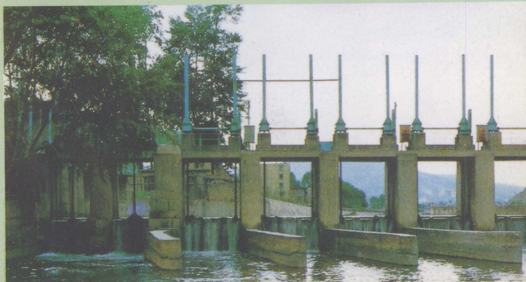
▽北川渠进水闸
