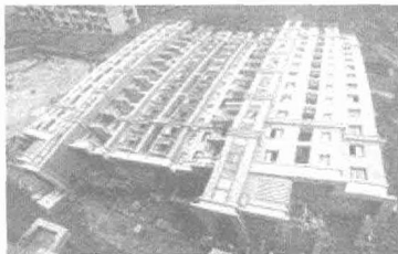
图 2-2 上海楼房倒塌事故
