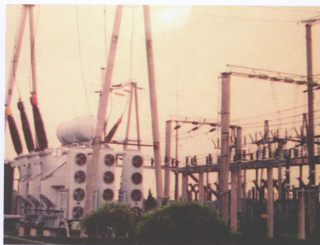
彩图 1-45 西安南二环上的由少油断路器等组成的传统 110 kV 变电站
