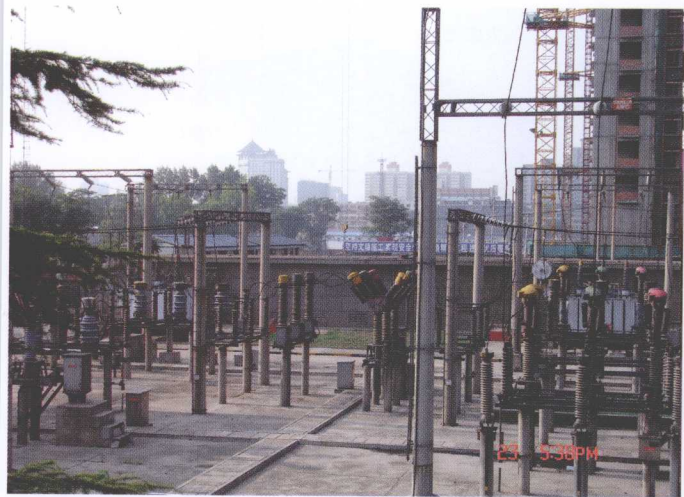
彩图 1-45 西安南二环上的由少油断路器等组成的传统 110 kV 变电站
