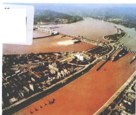
彩图 1-22 长江葛洲坝河床式水电站鸟瞰
