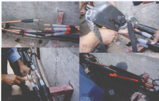
彩图 5-19 高压电缆接头的制备过程 ①接头制备;② 接头压接;③接头整形;④套热缩管绝缘
