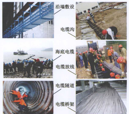
彩图 5-21 电缆的敷设现场
