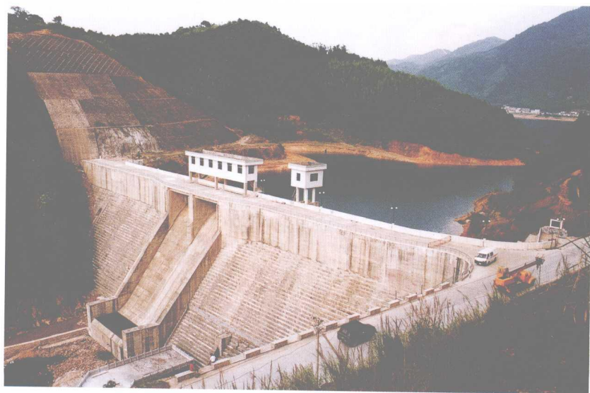
广州抽水蓄能电站下水库碾压混凝土坝
