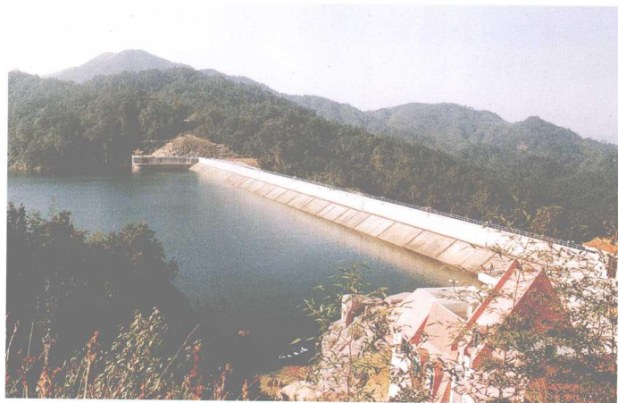
广州抽水蓄能电站上水库
