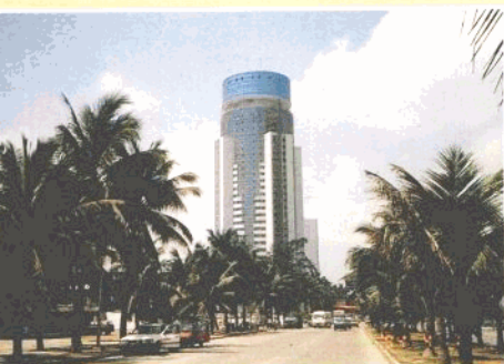
中国石化海南经济开发公司 建设的中国石化大厦。
