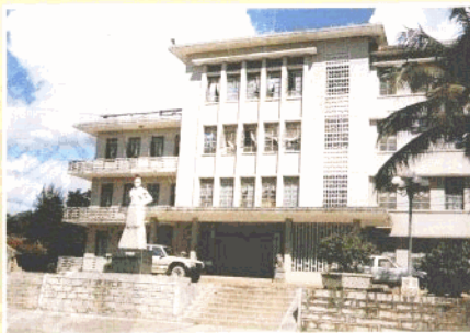
兴隆华侨农场办公大楼。
