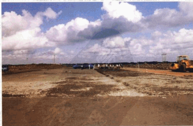
该局施工的美兰机场地基处理工程速度快质量好。
