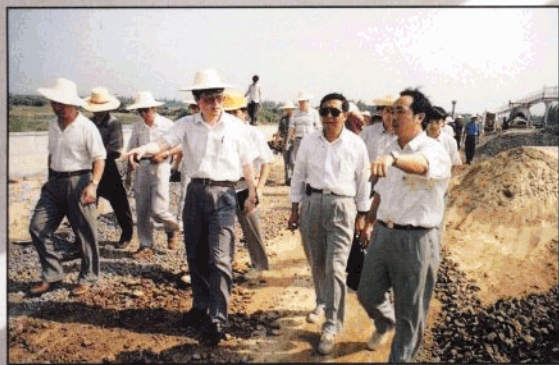
公司经理张春林(右一)陪同上级和有关部门负责人视察东线高速公路左幅扩建工地。
