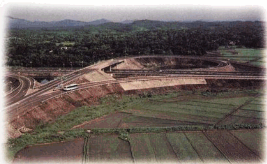
公司承建工程:东线高速公路琼海立交桥。
