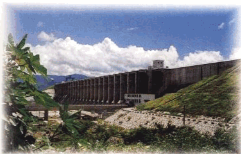
公司参与施工的海南省大广坝水电站工程。
