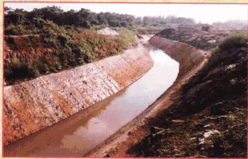
铁十二局保质保量完成了美兰机场河流改道部分工程。
