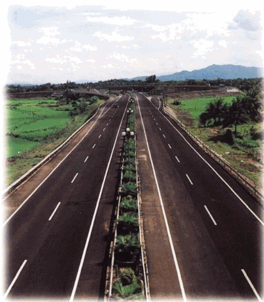
公司承建工程:东线高速公路琼海段。
