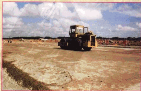
进行美兰机场主跑道施工。
