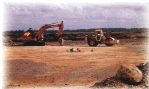
保质保量进行美兰机场场道地基处理工程施工。
