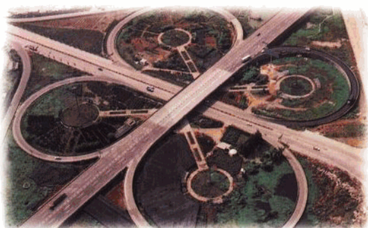
公司承建工程:府城高速公路互通立交全貌。
