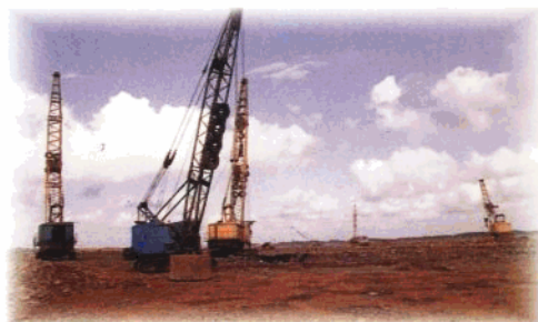
公司用大型先进设备对美兰机场场道地基实行强夯施工。
