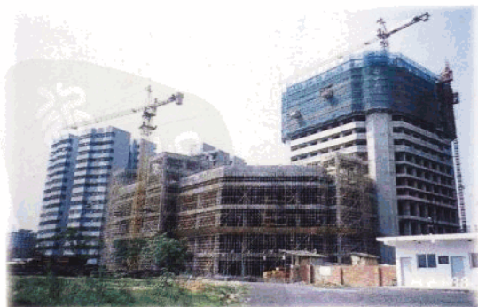
公司正在施工建筑的海南明光大酒店。
