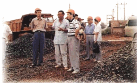
公司经理刘金焕、副经理沈锡荣亲临美兰机场施工现场检查指导工作。
