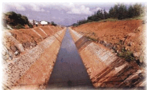
公司施工的美兰机场河流改道工程一段,已于1997年8月顺利通水。
