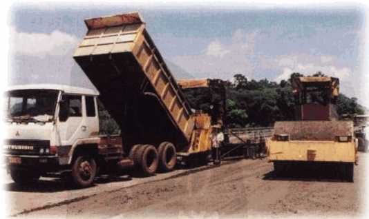
公司承建工程:东线高速公路扩建工程第十标段施工现场。
