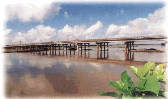
公司承建工程:东线高速公路南渡江大桥。
