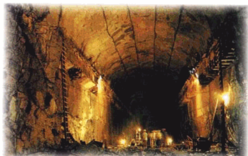
海南大广坝水利枢纽工程浅埋式地下厂房开挖及岩锚吊车梁施工,在国内处于领先地位。
