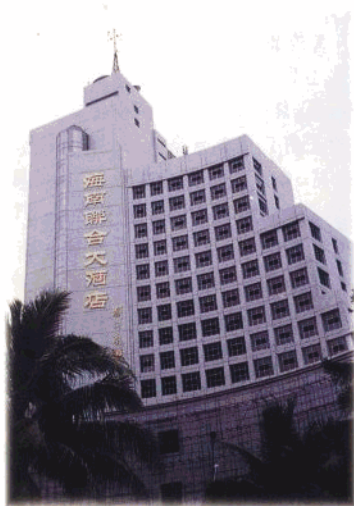
公司施工建设的海南联合大酒店。
