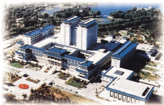
集团公司施工建筑的北京新图书馆。
