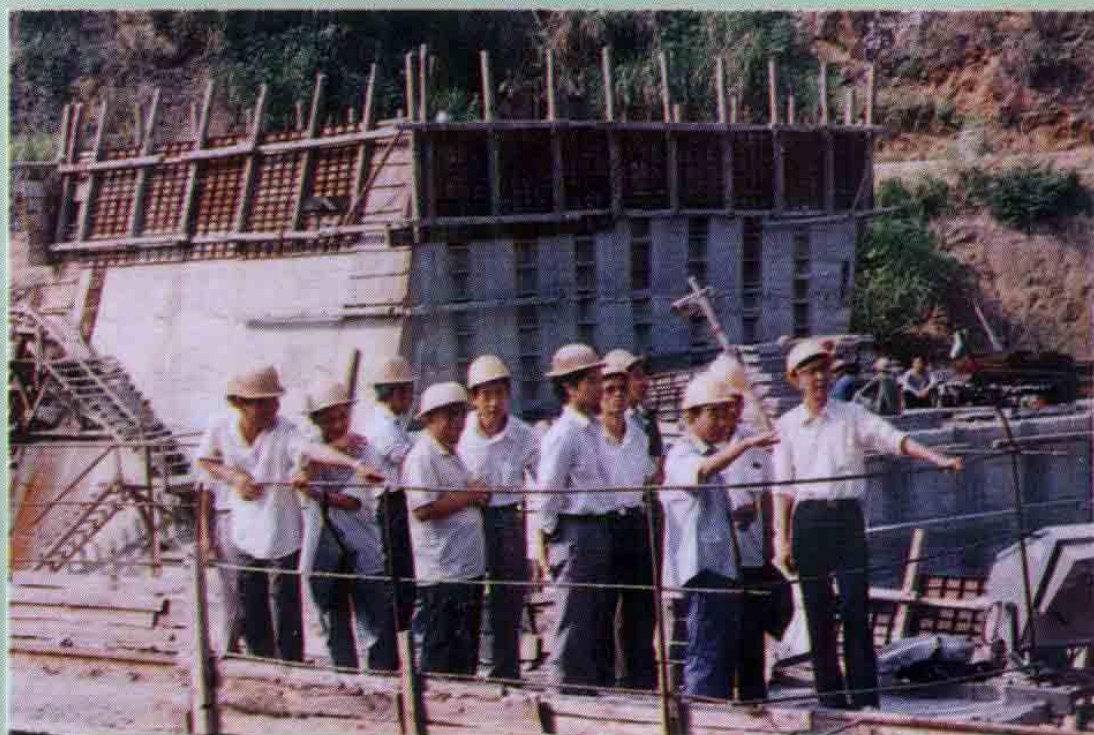
△水利部工程质量检查组在工地进行工程质量检查。
