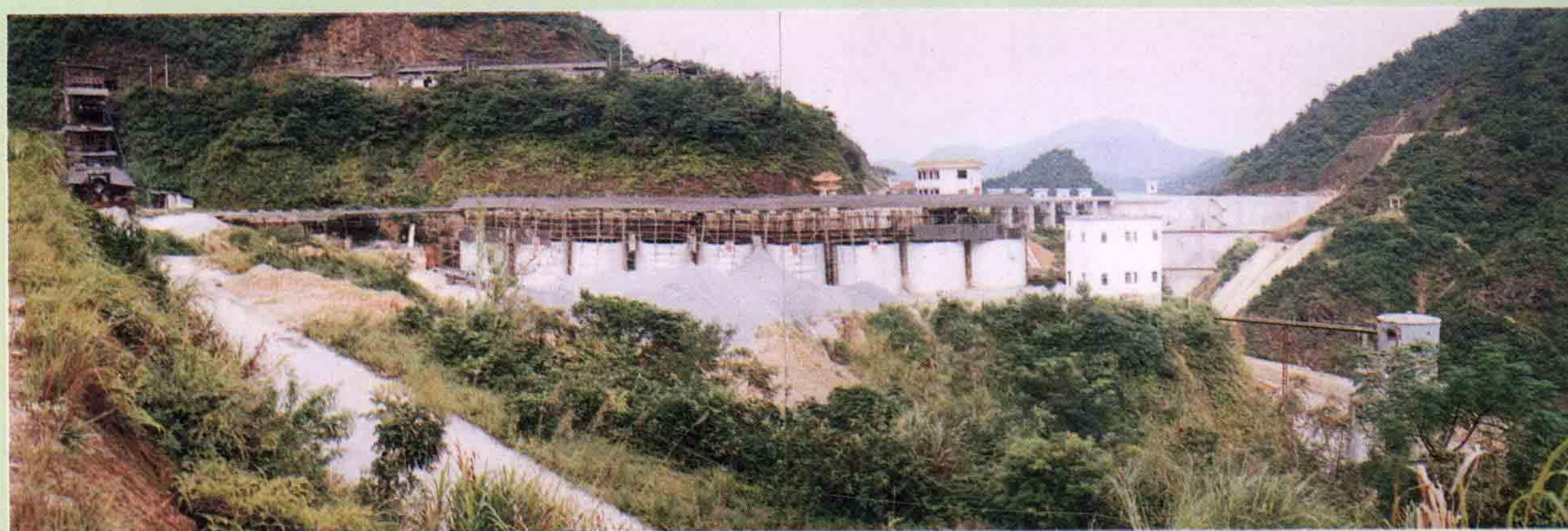
△工程施工系统。中间圆筒部分为砂石料仓，右为制冰楼。
