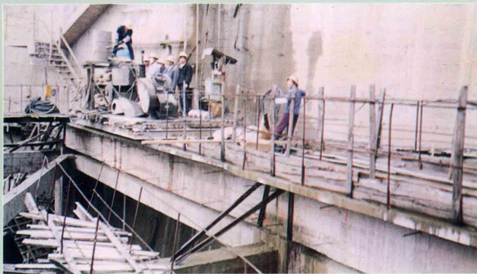
△拱坝封拱灌浆施工。
