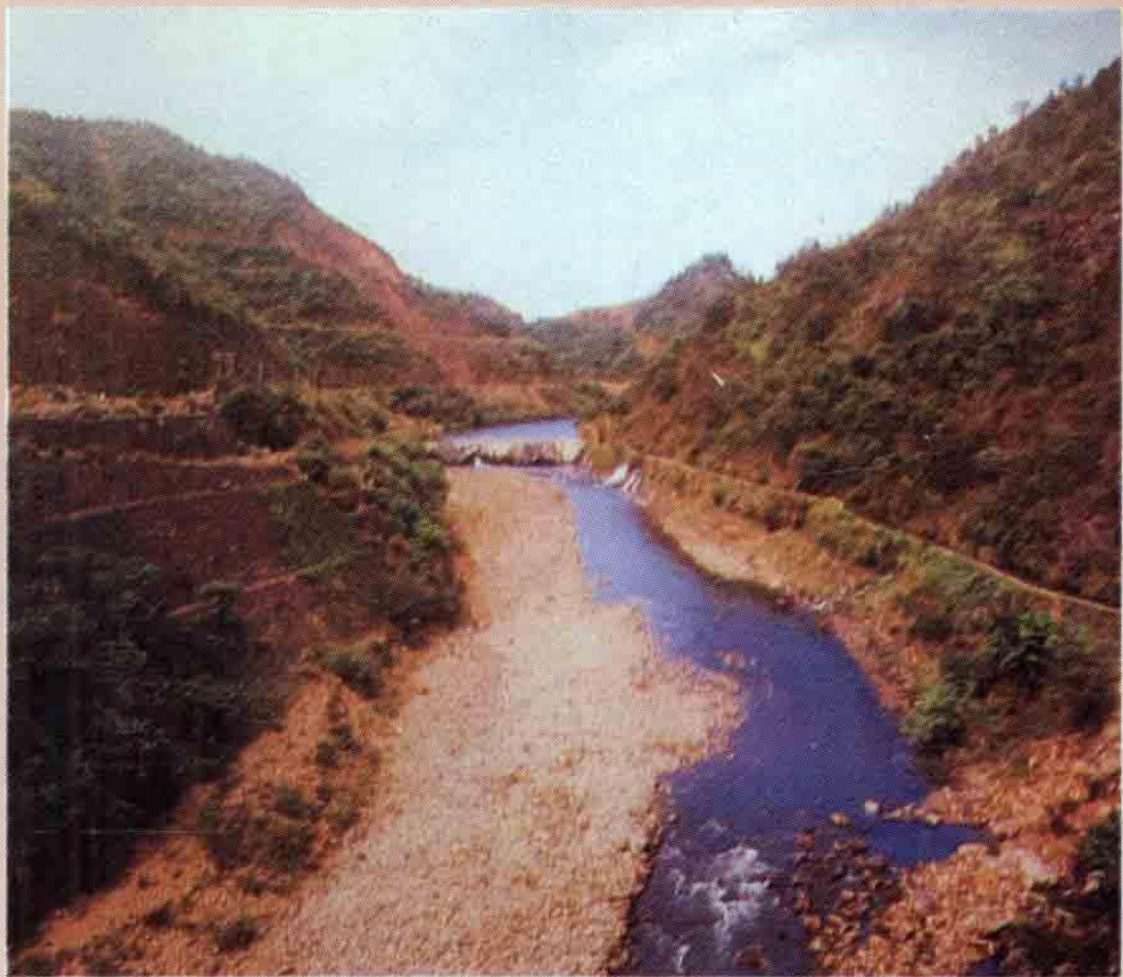
△天堂山拱坝坝址（翻摄于中国拱坝画册）。
