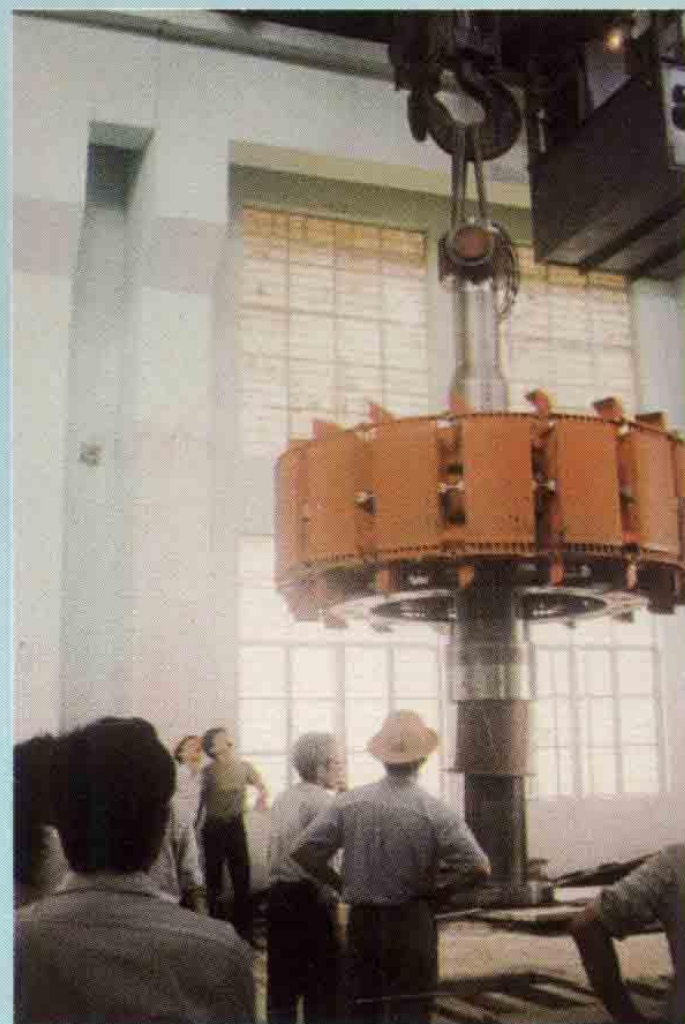
△安装机组转子。
