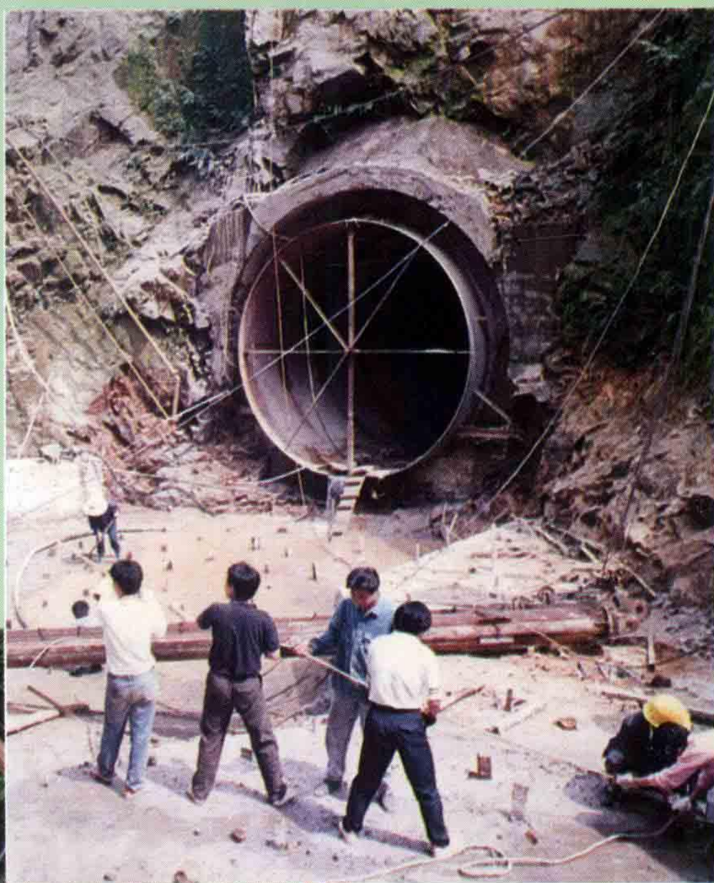
△引水隧洞高压 钢管出口处。
