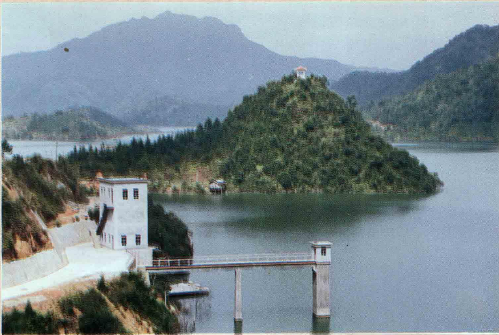
△引水隧洞进水口。 胡耀钧摄
