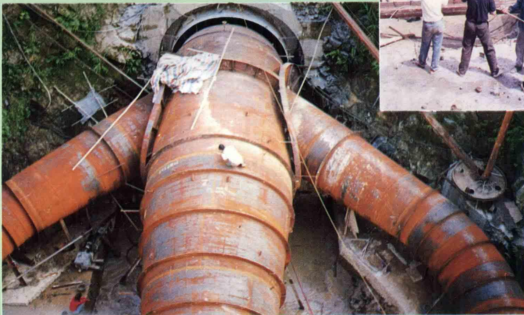
△水电站岔管施工。
