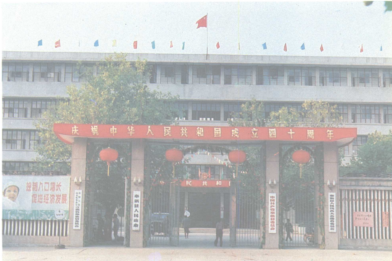
县党政机关办公楼
