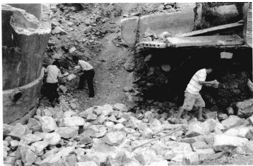
被洪水冲毁的水库坝基
