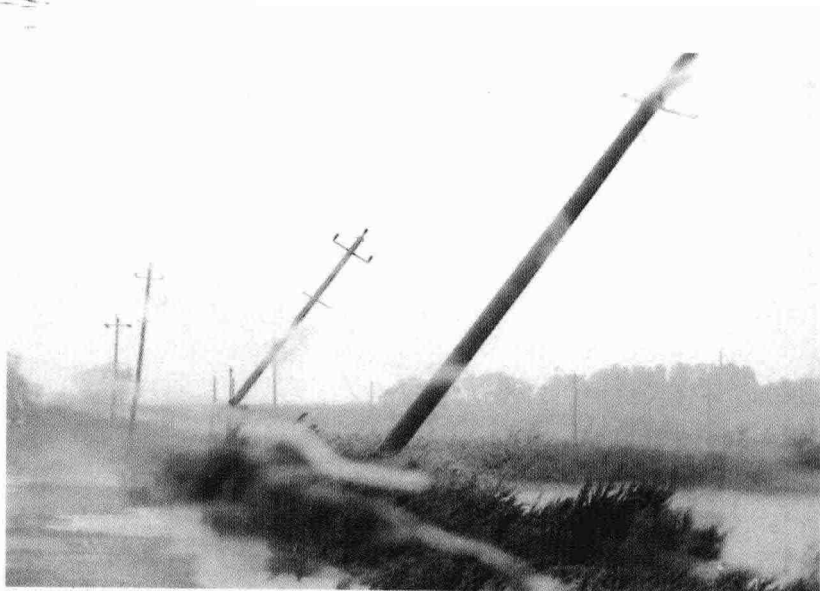
供电系统面临着严峻的考验
