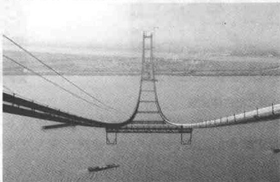
图 1.5 润扬长江公路大桥
