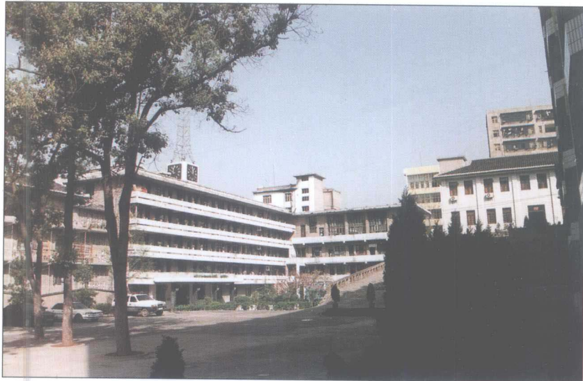
◀ 中共通江县委办公楼
