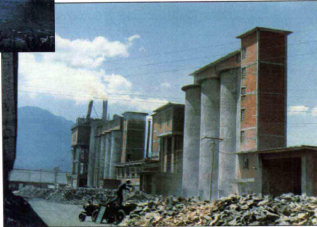
▶ 水泥厂生产区
