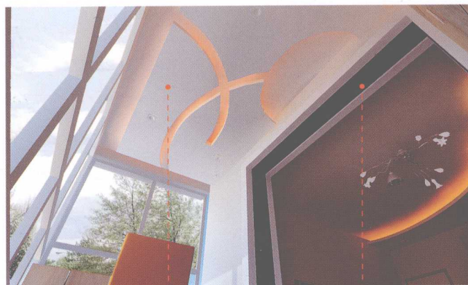
石膏板异型吊顶
