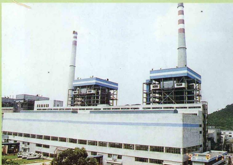
一局历年承建了许多重要的水电站、火电站和变电站。图为沙角电厂，装机3x200MW+2x300MW 5台机组已全部发电。
