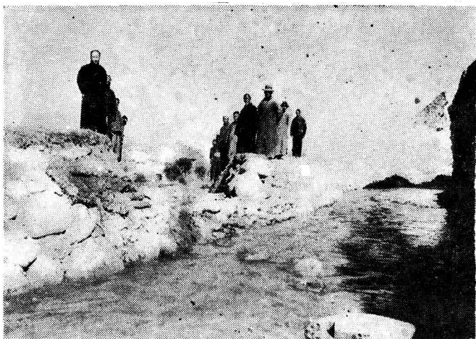
竣工理整壩頭左河渠金威武（上）
