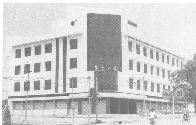
邮电大楼(建于 1992 年)
