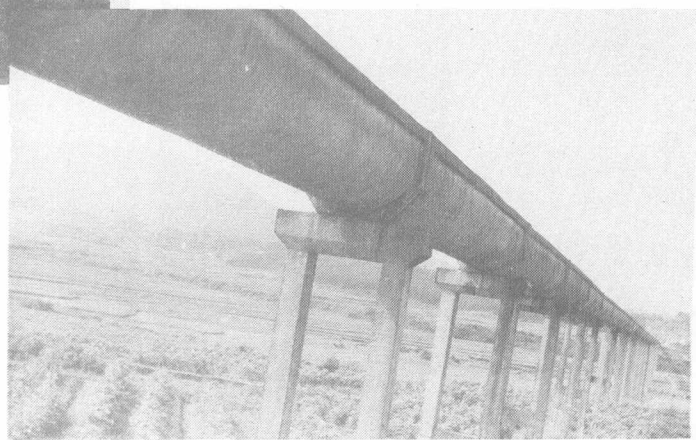
芳源渡槽(全长 630 米,最大架高 14 米,流量 3 立方米/秒)
