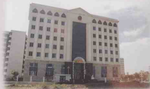
振东公安局办公楼
