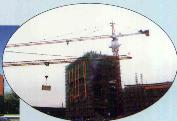
建设中的辽宁生物制药 研发中心主体工程
