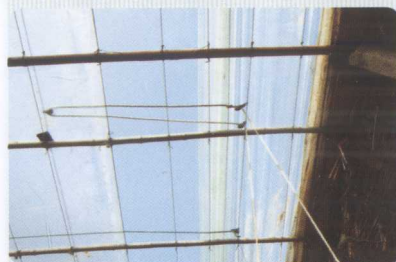
彩图2-5 通过天窗通风滑轮开关通风口
