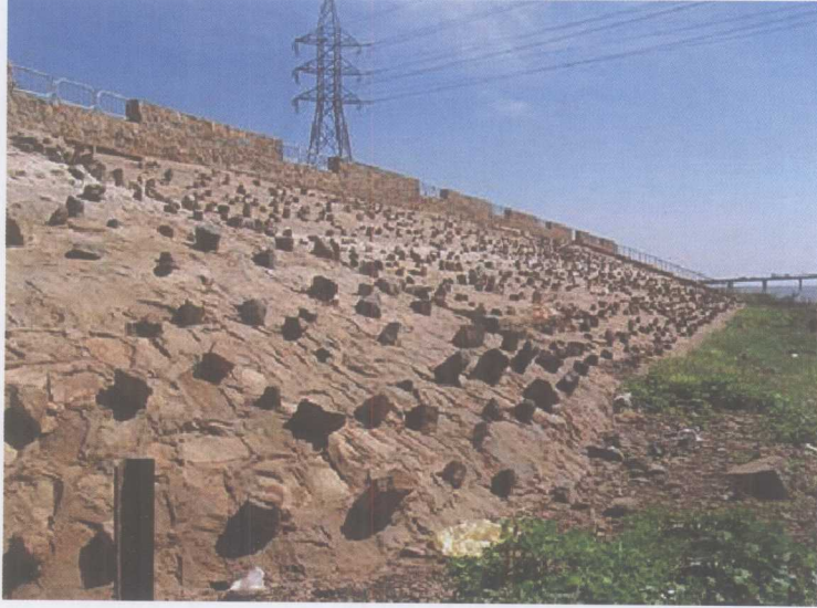
图 1.3 苏丹青尼罗河加糙的硬化河岸
