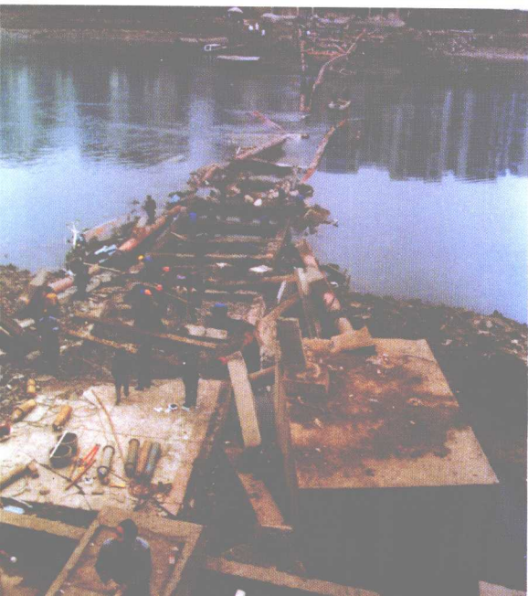
1999年1月4日 彩虹桥整体坍塌
