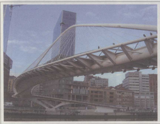
沃兰汀步行桥，变截面工字钢支架
