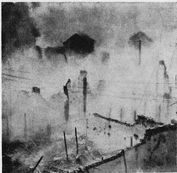
戰區建築物被燬情形
