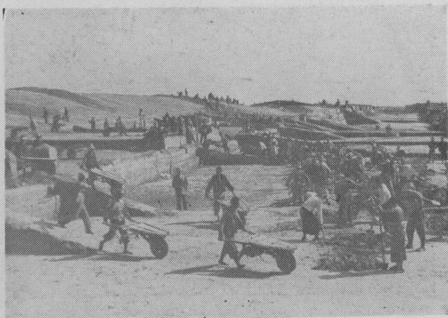
入海水道工程一般施工情形
