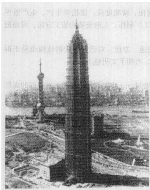
图 1-7 高层钢结构建筑
