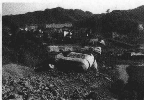
图 1-3 湖南省凤凰县堤溪沅江大桥“8·13”特别重大坍塌事故
