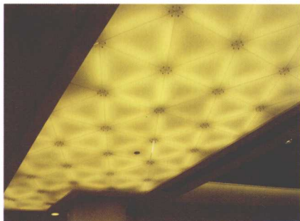
图1-14 半透明的磨砂玻璃装饰吊顶
