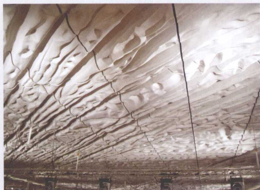
图 1-17 特制石膏的凹凸装饰质感
