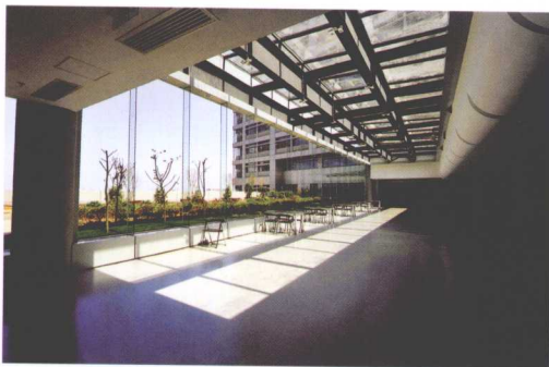
图1-21 多功能的办公楼玻璃采光顶 (工程案例)
