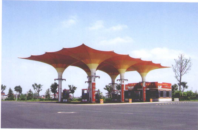
图1-25 张力膜结构是预先在工厂加工好,现场安装即可 (工程案例)
