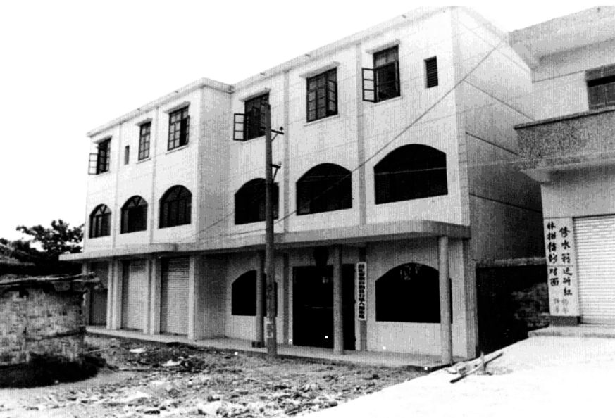
刚建成的石碌人民法庭
