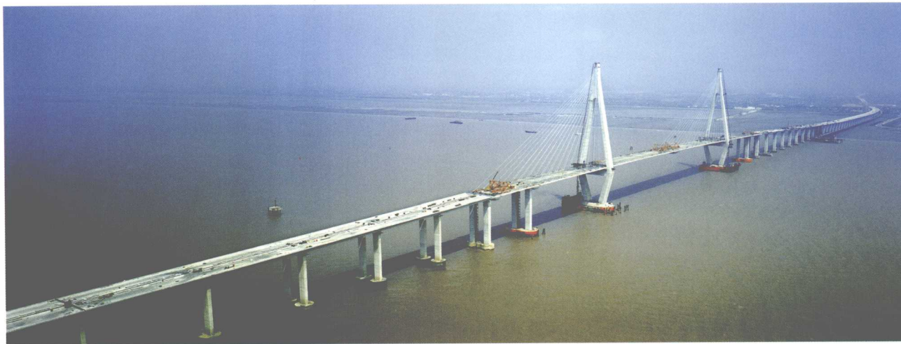
■ 建设中的杭州湾跨海大桥
