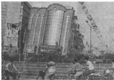
图 1.1 上海地铁施工引起高层建筑物倾斜
