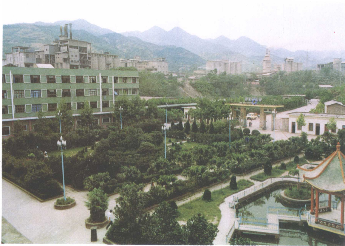
▲ 铁道部川东水泥厂
