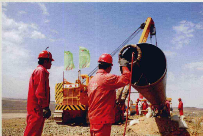
● 吐哈油建在西气东输施工现场作业
