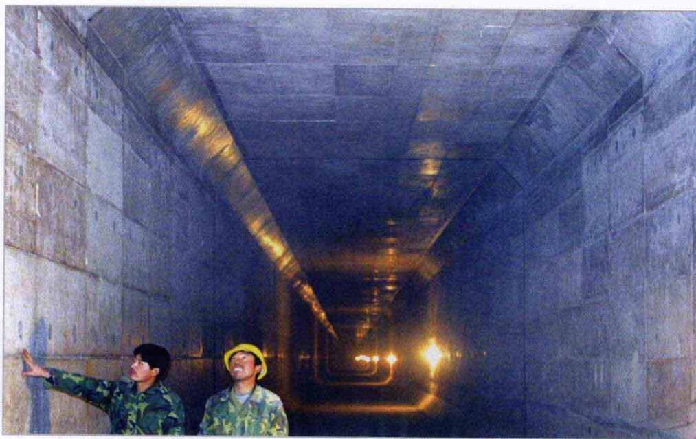
首批完工后的暗渠箱涵内景(钱进 摄)
