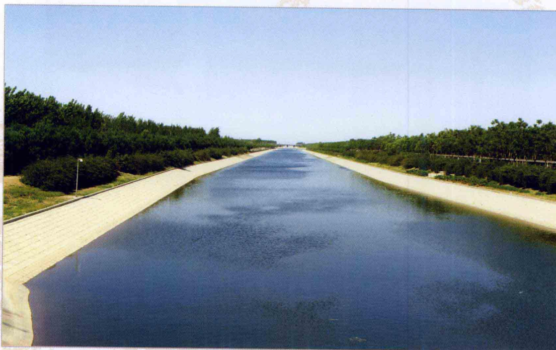
综合治理后的明渠（刘学民 摄）
