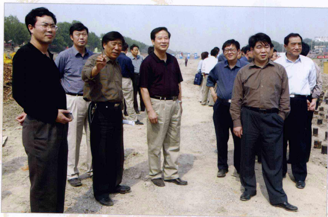
原天津市副市长孙海麟检查明渠工地 (张建华 摄)
