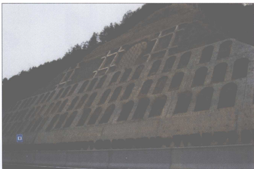
彩图 3 高速公路上的边坡防护工程
