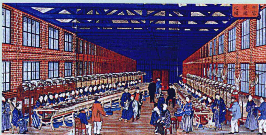
富岡繅絲廠。此厂于1872年建成开工，其目的是使生丝出口成为对明治新政权的生存至关重要的外汇来源，另外也可为前武士的女儿提供工作岗位。
