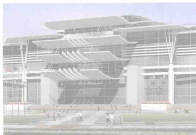
新建的湖南国际会展中心
