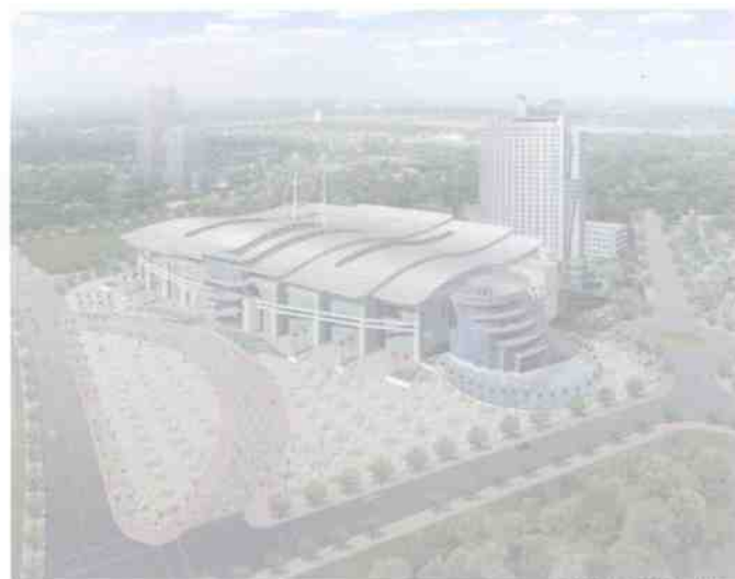
新建的湖南国际会展中心
