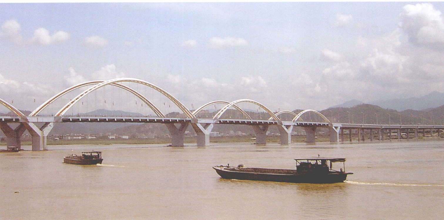
建成后的金山大桥全景
