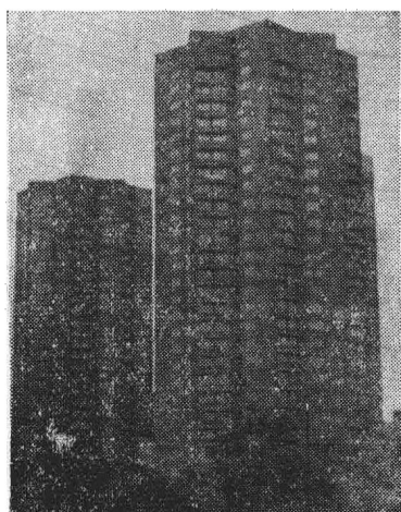
F. 新建钢模现浇八角形住宅
