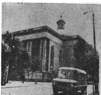
C. 钢筋混凝土拱形讲经大教堂前面
