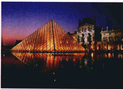
图1-4 贝聿铭设计的卢浮宫扩建工程
