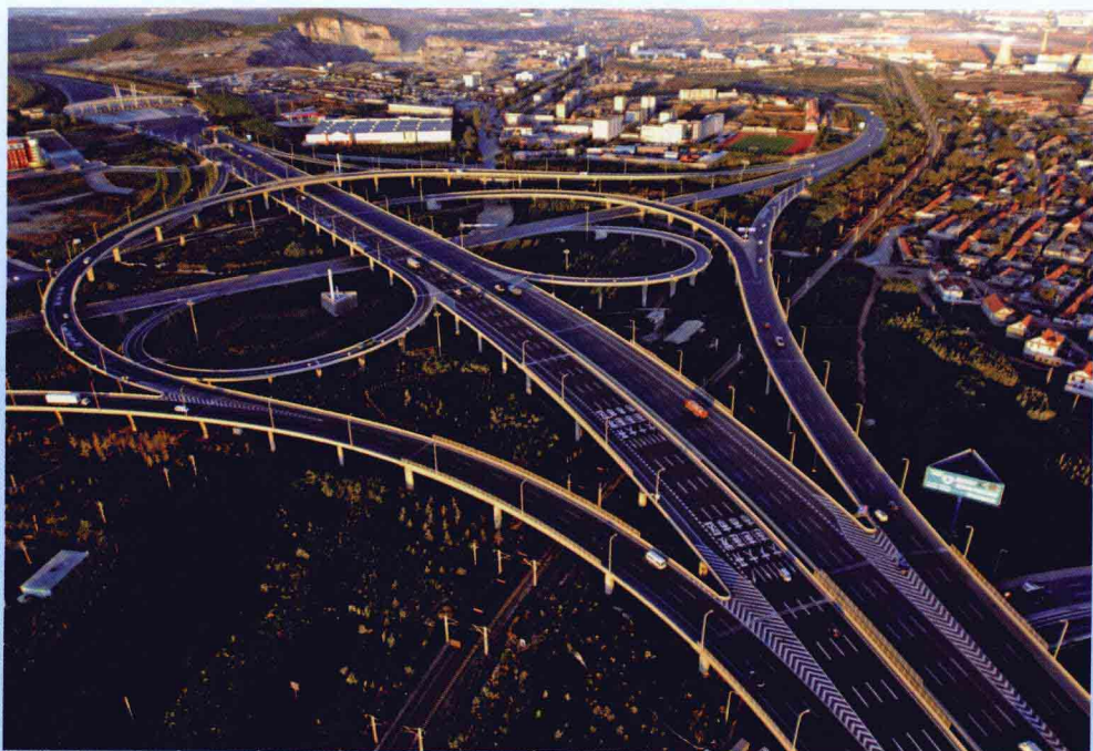
◎ 沈大高速公路后盐立交桥
