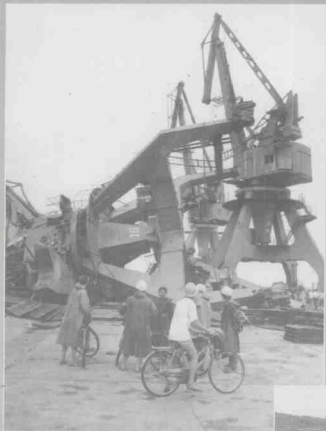
▲ 被1996年9615号台风掀翻的湛江港龙门吊
