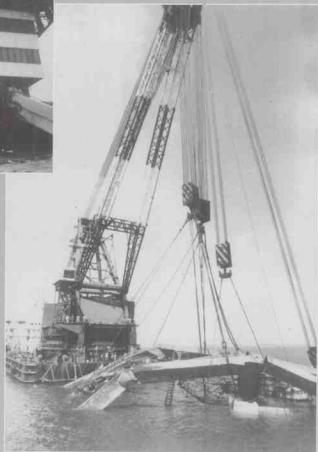
▲ 湛江港正在抢吊被9615号台风掀翻下海的龙门吊车 (郑锋摄)
