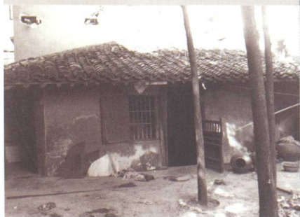
余石出生地泾南村杨家宅12号其父亲祖传的老房子（灶间门外一角）
