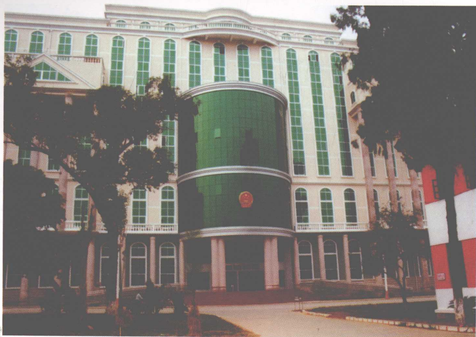
县行政综合办公大楼
