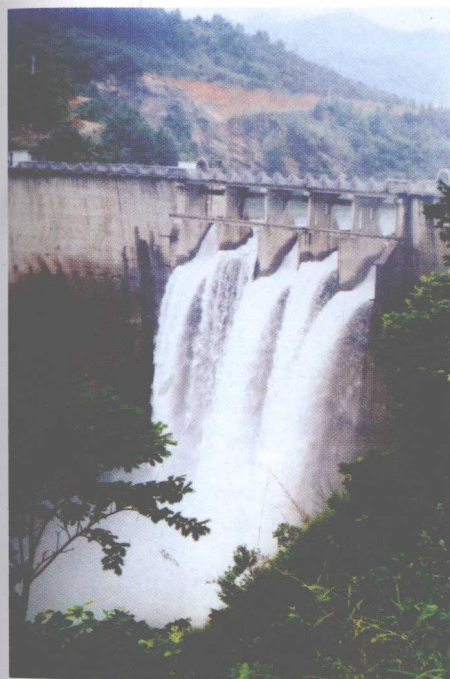
所略梯级水电站坝首泄洪景观
