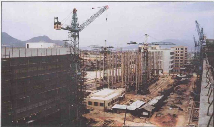
建設中的湖里工業區工地一瞥
