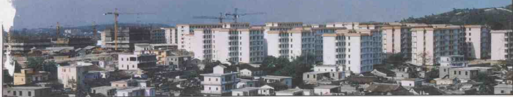
廈門蓮花新村建設工地
